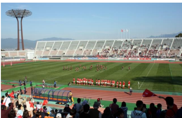
改修工事が終わったニスタのバックスタンド
